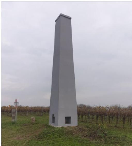
Trigonometrijska točka I. reda – 259 Kamenjak nalazi se na brijezu Kamenjak, u središnjem dijelu brda Banska kosa, u okolini Kneževih Vinograda. Iznad trigonometrijske točke izgrađena je signalizacija u obliku građevine – geodetske piramide, koja je služila za potrebe prve trigonometrijske izmjere SFRJ 1946. godine.
